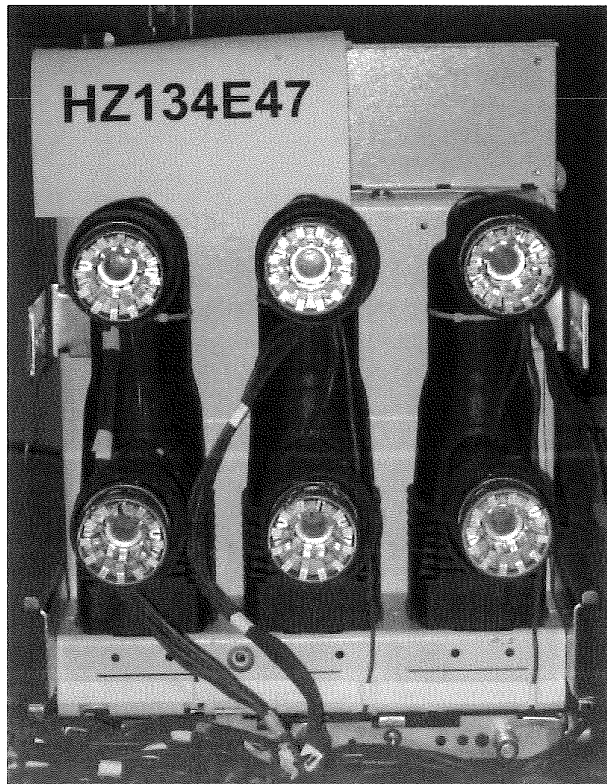
Fig. 8: Circuit-breaker VM1 17.06.25
